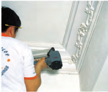
7. Vor Vernagelung prüfen Sie die Passgenauigkeit der Verbindung.
