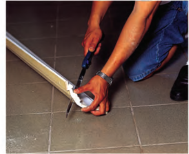
3. Schneiden Sie das Gesimsband an den Markierungen.
