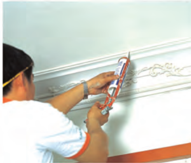
8. Zum Verfüllen der Nähte benutzen Sie den Klebstoff.
