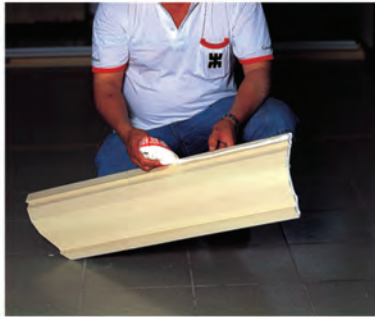
4. Tragen Sie Klebstoff an die Rückseite des Simses längs der Kanten und vollflächig auf die Oberfläche, an die die Simse geklebt werden.
