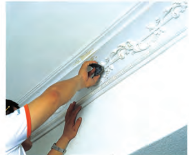
9. Die Oberfläche wird mit Sandpapier geöltet.
