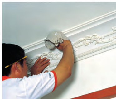
10. Entfernen Sie die überstehenden Reste des Klebstoffs.
