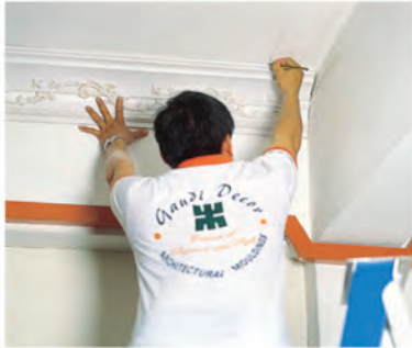
1. Markieren Sie an dem Gesimsband Anschlussstellen in den Ecken
