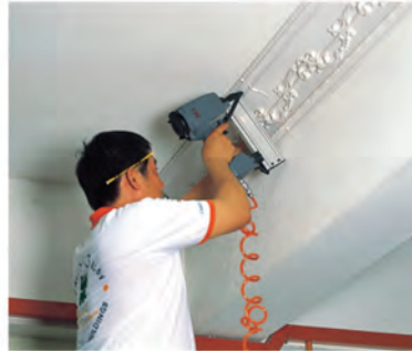
5. Zum Vernageln benutzen Sie eine Pressluftpistole.
