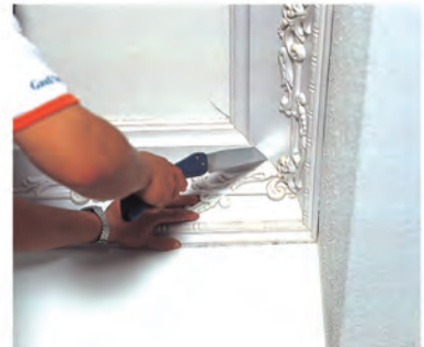
6. Passen Sie die Gesimsenden an, damit sie an Verbindungsstellen sauber anliegen.
